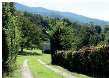
Accès enherbé, bandes de roulement en grèves
